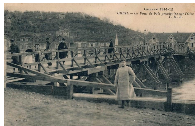
Le pont de bois provisoire en 1915.
